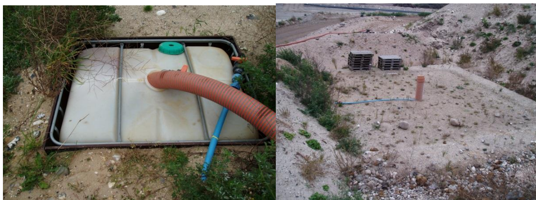
Figur 4-2 På billedet til venstre ses pallettanken, som vandet pumpes over i før det på kort tid ledes til fordelingsbygværket. På billedet til højre ses overfladen af fordelingsbygværket over forsøgscellerne 1-4 med det centrale fordelingsrør i midten.
